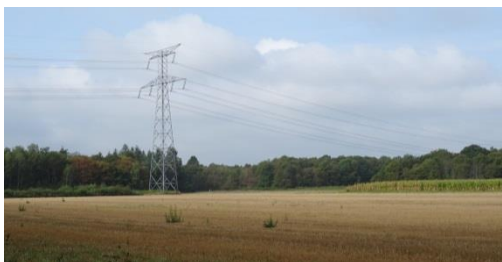
Figure 62 : Espace agricole traversé par une ligne à haute tension
