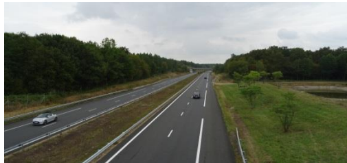
Figure 65 : Autoroute A77 en limite Nord-Est de la commune
