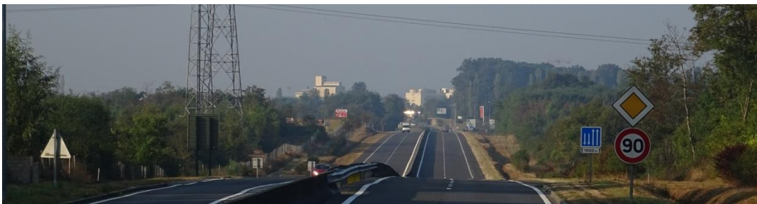
Figure 12 : Vue de Gien depuis le giratoire de la Métairie Neuve sur la RD 940
