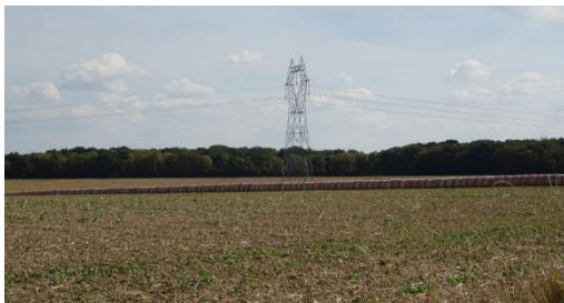
Figure 84 : Le plateau agricole traversé par une ligne haute tension avec la forêt de Saint-Brisson en arrière-plan
