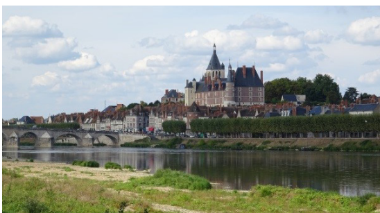
Vue sur le château de Gien depuis la rive Sud
