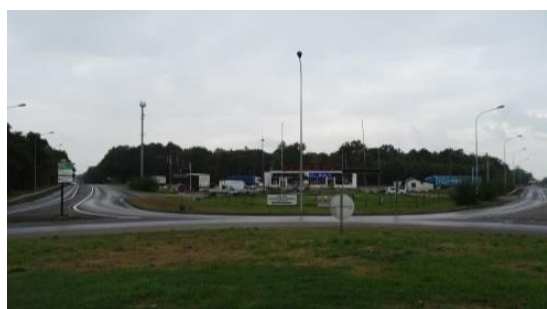
Jonction entre la RD 2007 et la RD 940
