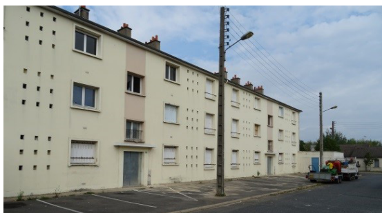
Immeuble inoccupé aux abords du lycée
