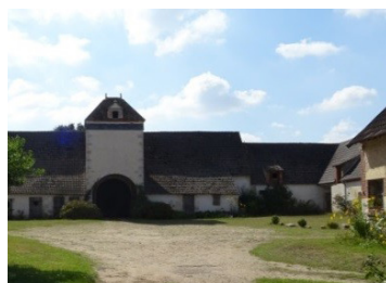
Bâtiment à Nouan commune de St-Gondon
