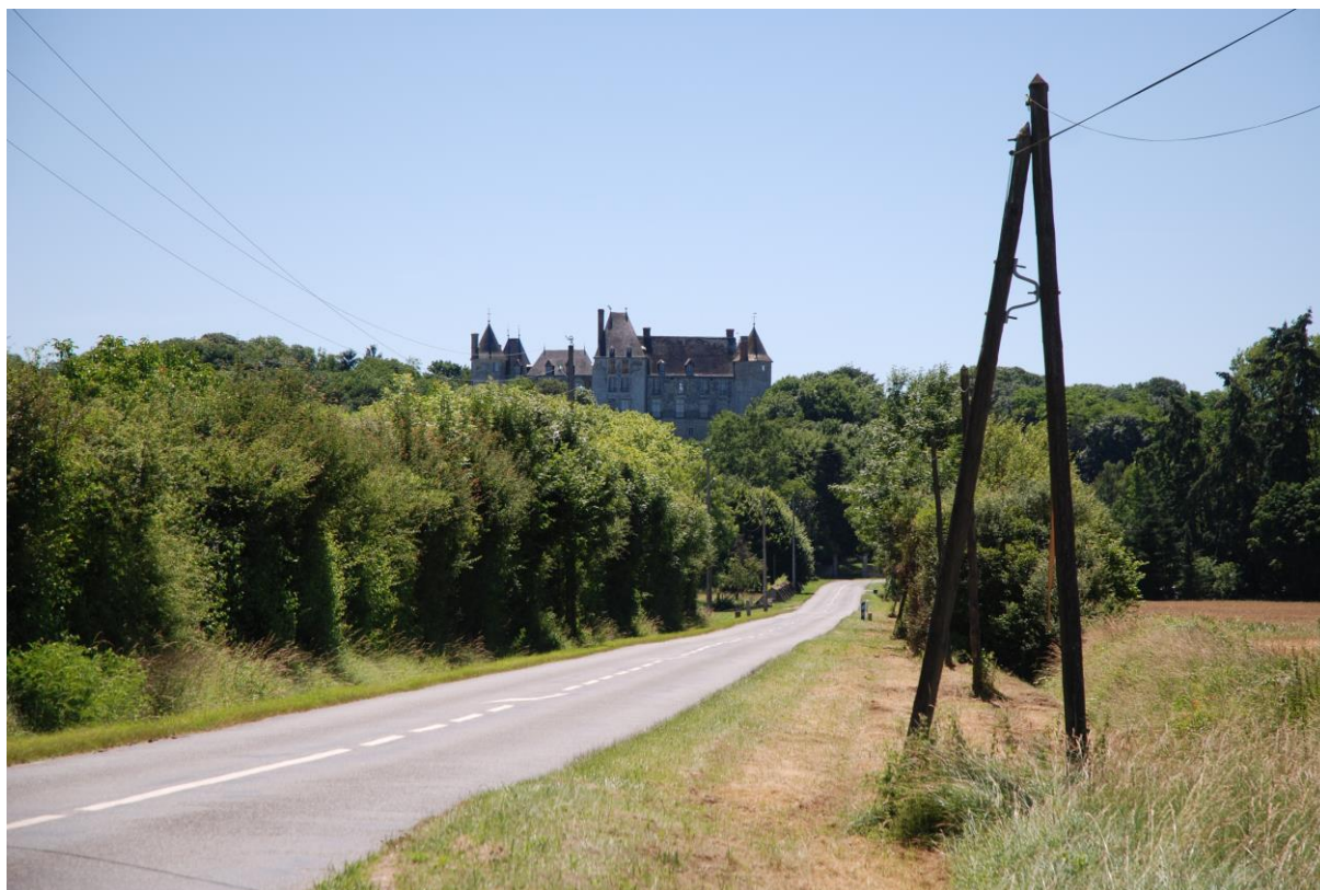
Entrée de ville – le château émergeant de la masse végétale,
