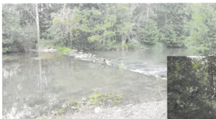
Figure 23 : Avant / Après : effacement du seuil de Conflans sur Loing avec implantation de banquettes - LOING AMONT
