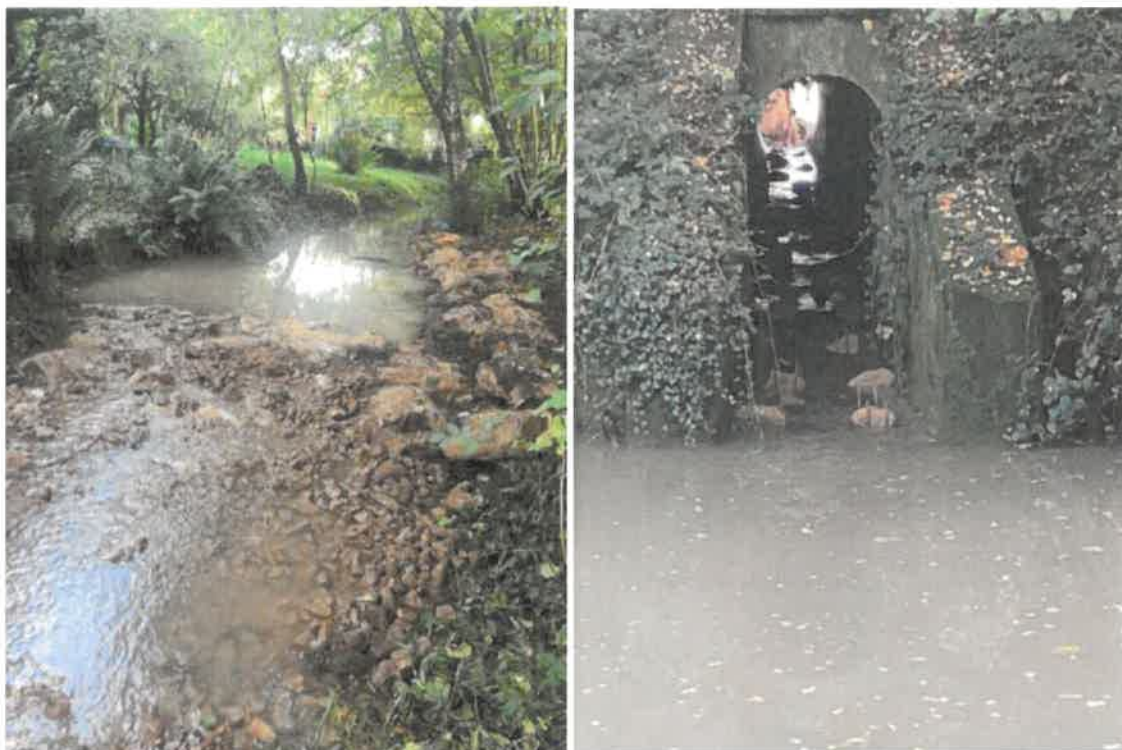
Figure 25 : Seuil et passage sous la route franchissable - LOING AMONT
