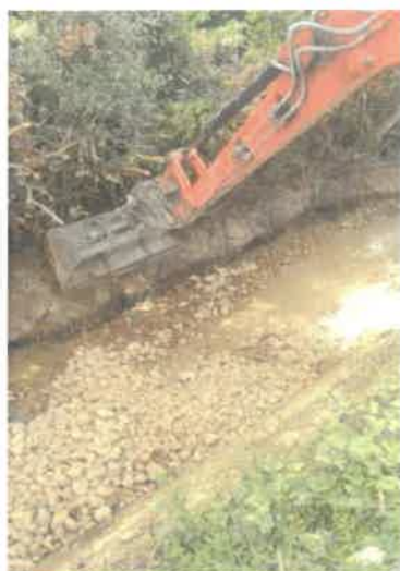
Figure 61 : Recharge granulométrique (silex) sur l'ensemble du tronçon - CLERY
