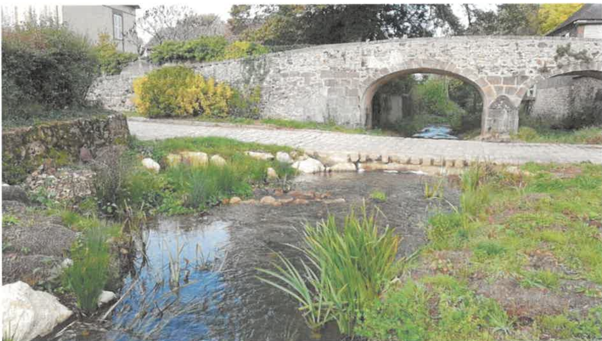
Figure 17 : vue après travaux sur le passage à gué – Mézilles (89) – OUANNE AMONT
