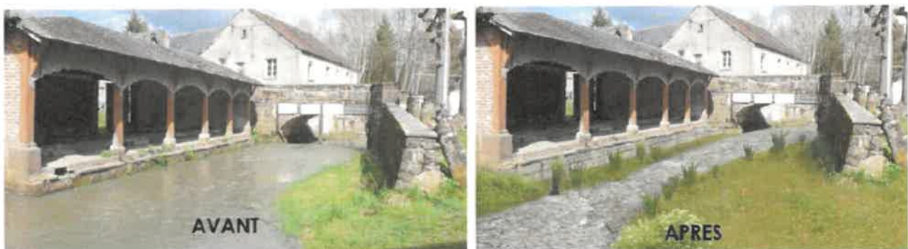
Figure 16 : Photomontage avant-après travaux au droit de l'Ouvrage du lavoir – SOURCES DU LOING
