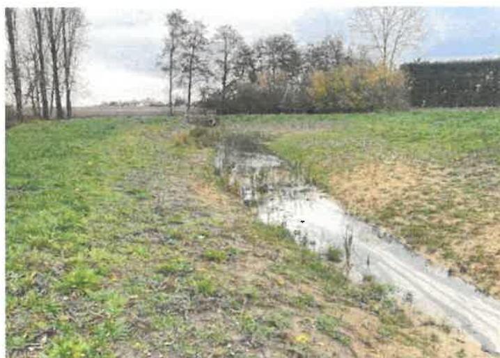
Figure 47 : Les eaux pluviales de la ZA et des drains agricoles sont désormais captées et épurées par la végétation de la zone humide aménagée au sud du site - BEZONDE
