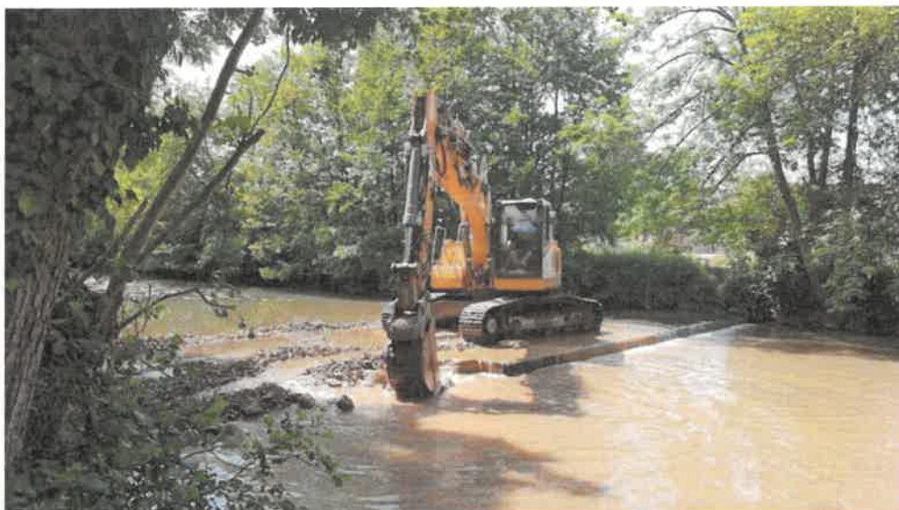
Figure 21 : Suppression du seuil du camping de Montbouy – LOING AMONT
