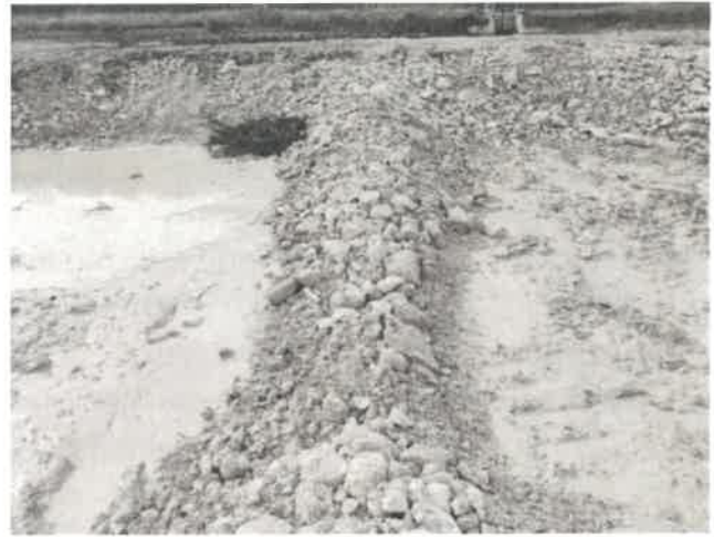
Figure 57 : Vues des seuils avant mise en eau de l'ouvrage - LOING MEDIAN
