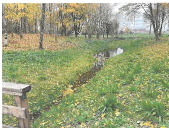
Figure 45 : La zone humide située au nord du site permettra d'assurer une phyto-épuration des eaux de ruissellement de la plaine agricole (PA) - BEZONDE
