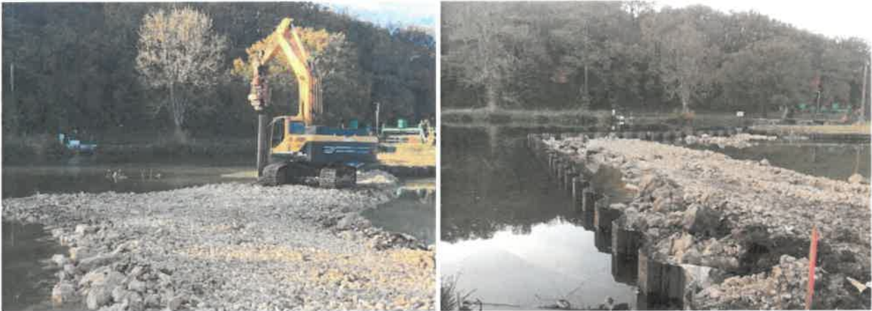
Figure 56 : Le premier rideau de palplanche servira de batardeau pendant toute la durée des travaux - LOING MEDIAN
