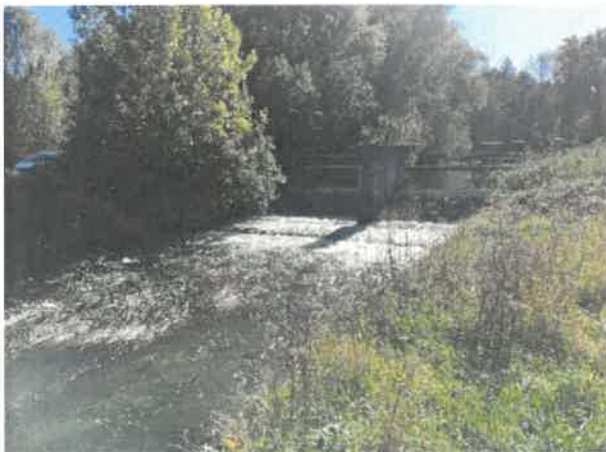
Avant travaux (Septembre 2021)
