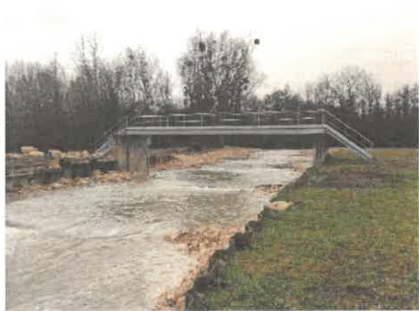
Après travaux (mars 2022)
