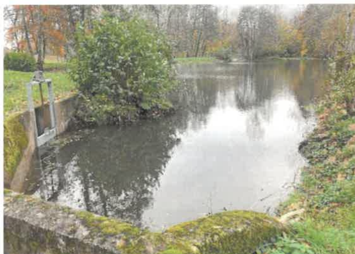
Figure 46 : L'étang de Jobert a été aménagé afin d'augmenter sa capacité de stockage en période de crue - BEZONDE
