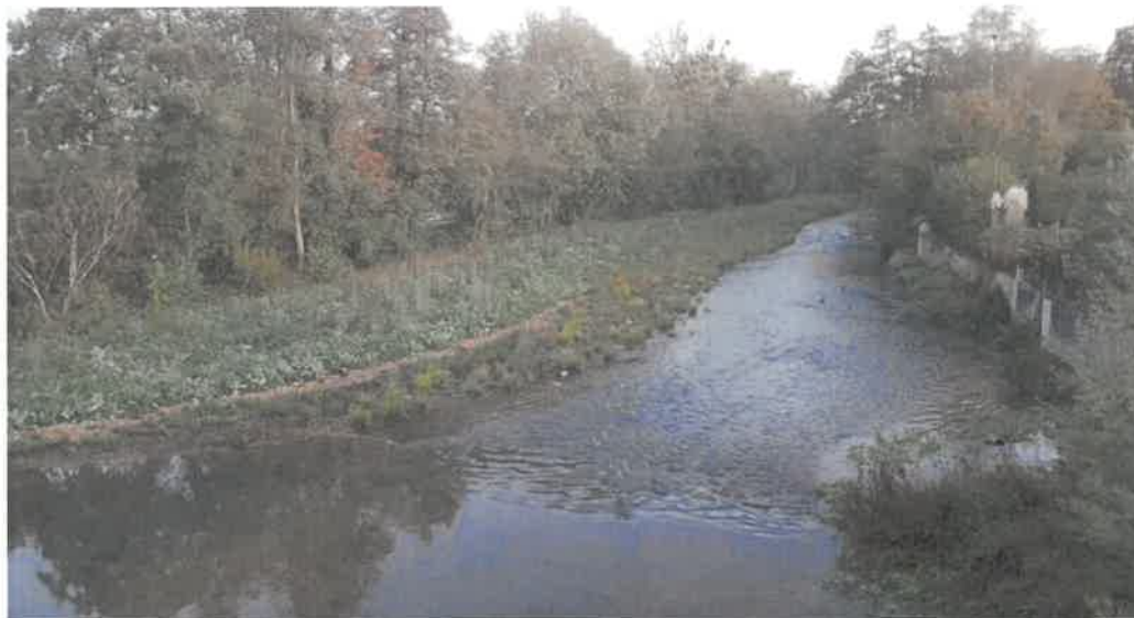
Figure 22 : Vue amont du Loing suite à la suppression du seuil et l'implantation d'une banquette en rive gauche - LOING AMONT
