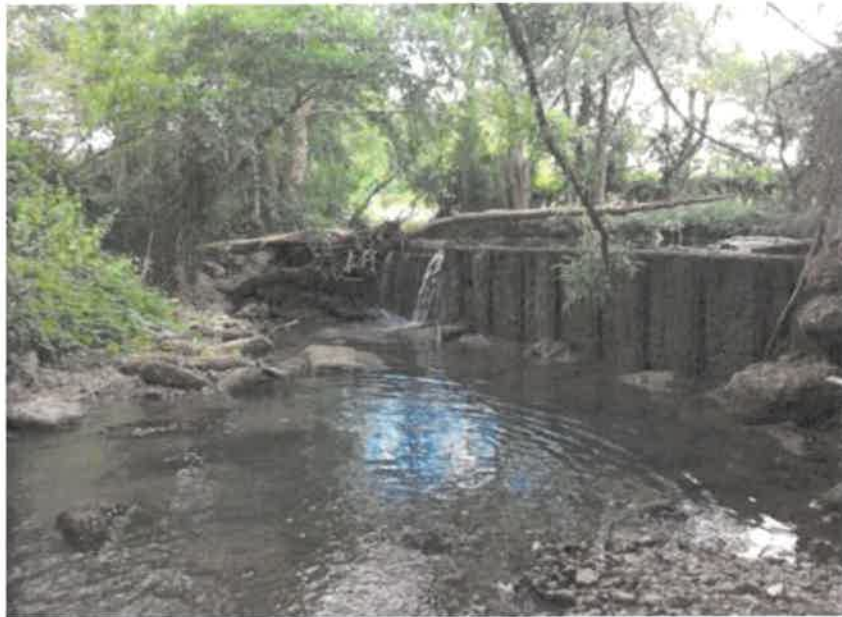
Figure 63 : Déversoir, le plus récent, du moulin Brandard - BETZ
