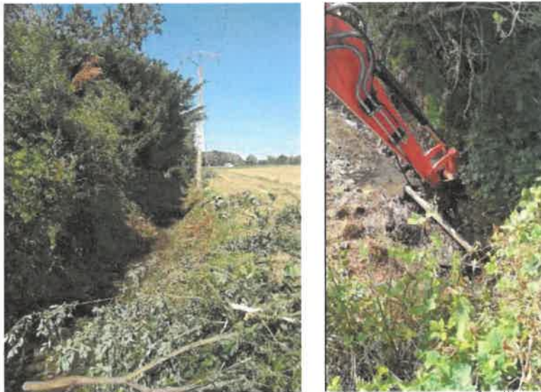
Figure 59 : Entretien de la végétation (à gauche) et suppression des sédiments pollués (à droite) - CLERY
