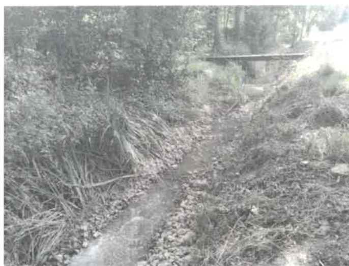
Figure 61 : Recharge granulométrique (silex) sur l'ensemble du tronçon - CLERY
