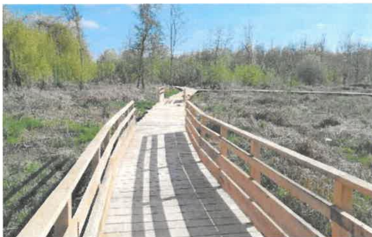
Figure 75 : Photographie du platelage en cours de réalisation
