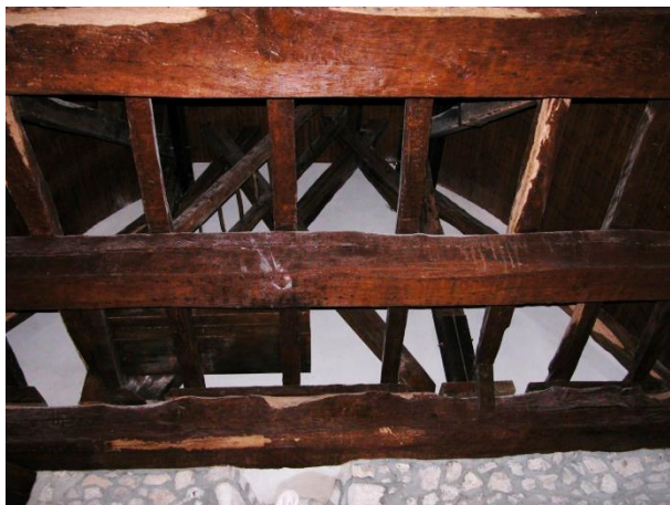
détail charpente soutenant le clocher
