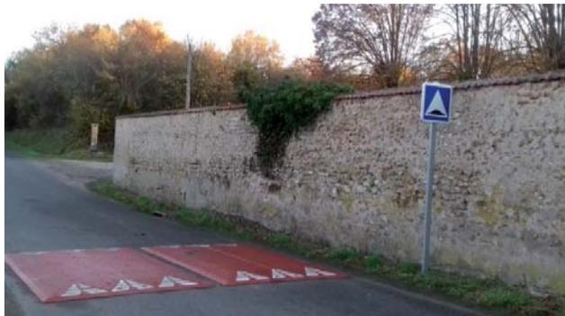
Le coussin berlinois est une surélévation implantée sur la chaussée. A la différence des ralentisseurs il ne s'étend pas sur toute la largeur de la chaussée. Le coussin permet aux véhicules de transports en commun et aux poids lourds de le franchir en atténuant l'effet de surélévation. Seuls les véhicules légers, du fait d'un espace moindre entre les roues, sont obligés de rouler sur la partie surélevée soit avec les roues de droite, soit avec les roues de gauche.
